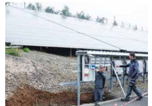
Eigener Strom: Die neue Solaranlage wird gerade angeschlossen.
